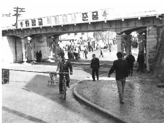
확장 공사 직후의 화명철교
