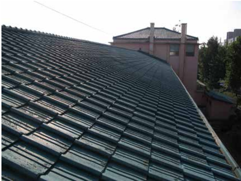
인천교대 본관과 연결된 회랑의 지붕.
